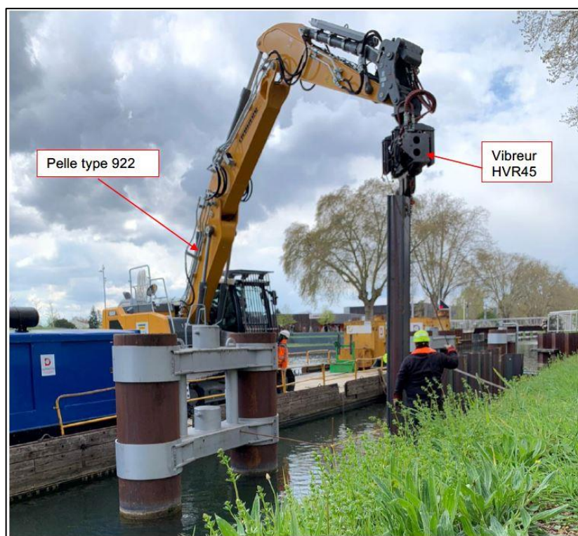
Figure 28: Engin utilisé pour le vibrofonçage
