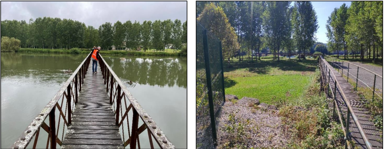
Figure 3 : Vues de la largeur de la passerelle (gauche) et de l'estacade (droite)
