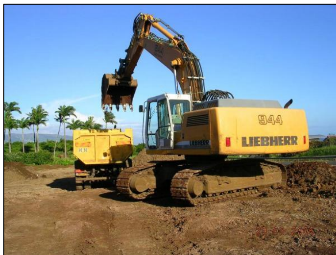
Figure 32: Engin utilisé pour le terrassement
