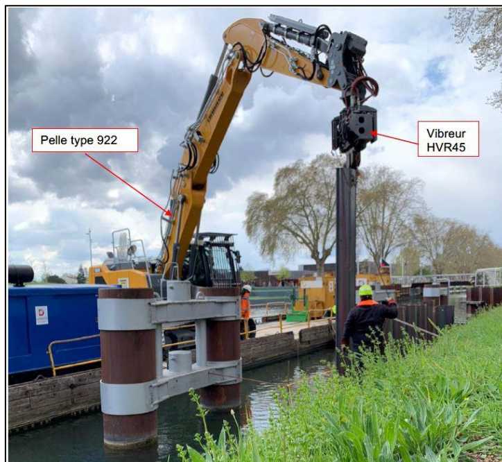
Figure 30: Engin utilisé pour le fonçage
